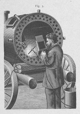
Die Wirkung des Lichtbogens ist ähnlich wie die der Stichflamme eines Gaslöthrohres, eine nur örtliche; nur diejenigen Metalltheile, welche wirklich schmelzen sollen, werden hoch erhitzt, während die der bearbeiteten Stelle entfernter liegenden Theile nur verhältnissmässig wenig durch Leitung und Strahlung erwärmt werden. Das flüssig gewordene Metall wird daher, unmittelbar nachdem der Lichtbogen zu wirken aufgehört hat, wieder starr.
