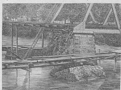
hat sehr grosse Aehnlichkeit mit derjenigen bei der Birsbrücke der J. B. L. Bahn im Jahre 1881 (September) bei Mönchenstein vorgekommenen, deren umgestürztes Widerlager dann durch ein pneumatisch fundirtes ersetzt wurde, um der Gefahr bei neuem Wehrbruch (Industriecanal Basel) zu begegnen. Für Moudon ist die Frage, ob pneumatische Fundation oder nicht, noch im Stadium der Prüfung, man will vorerst die Resultate neu angefangener Sondirungen der Flusssohle abwarten, ehe man sich entscheidet.
