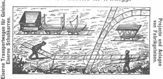
Specialität in tragbaren Stahlgeleisen für Feld-, Dienst- und Industriebahnen. Nicht zu verwechseln mit sogen. fliegenden Geleisen, da die Schienen und Schwellen unzertrennbar zu einem Geleisestück zusammengenietet und deshalb sofort zum Legen bereit sind.
