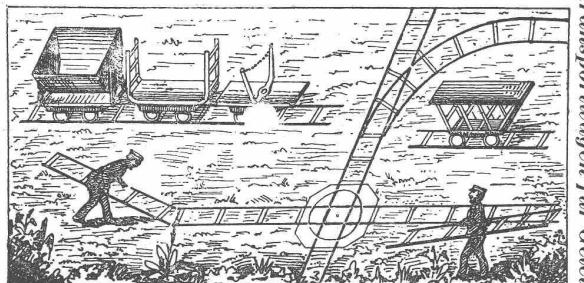
Leichte fliegende Stahlgeleise für Bauzwecke
