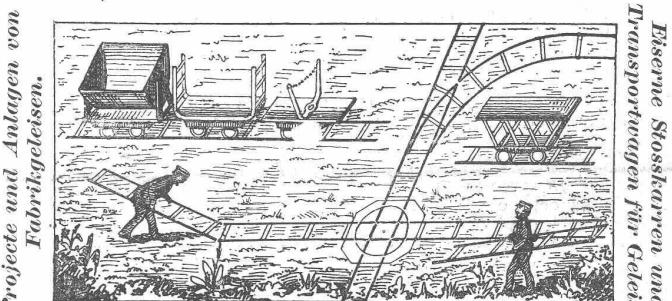
Leichte fliegende Stahlgeleise für Bauzwecke
