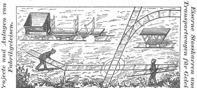
Leichte fliegende Stahlgeleise für Bauzwecke
