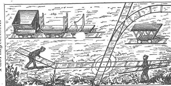
Leichte fliegende Stahlgeleise für Bauzwecke
