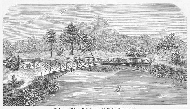
Trägerwellblech-Brücke von 16 Meter Spannweite mit Wellblech-Widerlagern im Park der Hygiene-Ausstellung zu Berlin ausgeführt von L. BERNHARD & Co. in Berlin.
