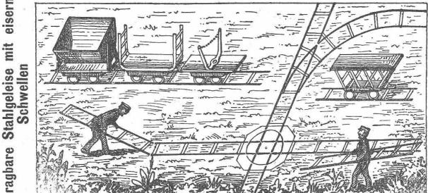
Tragbare Stahlgleise mit eisernen Schwellen
