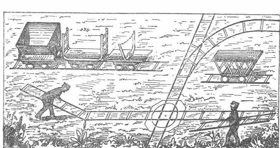
Tragbare Stahlgleise mit eisernen Schwellen
