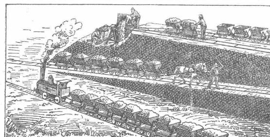
**Transportable und fixe Rollbahnen**, von 400mm Spurweite an, mit Hand-, Pferde- und Dampfbetrieb, für industrielle und landwirtschaftliche Etablissements, Lager- und Zeughäuser, für Bauzwecke etc.
