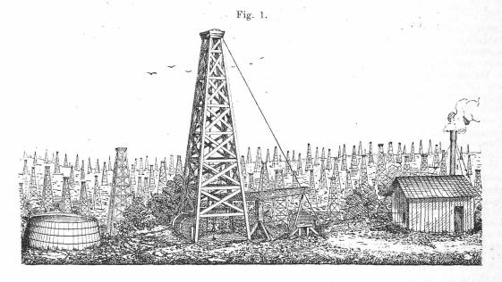
Die durchschnittliche Zeit, während welcher ein Well productiv ist, beträgt 2 Jahre 10 Monate und wenn man die Production während dieser Zeit nach dem mittleren Tagesdurchschnitt von 10,7  $\mathcal{H}_l$  berechnet, so ergibt sich für die Gesammtproduction jedes Bohrloches 10 500  $\mathcal{H}_l$ .
