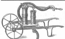
Transportable Schlamm- u. Wasserpumpen, vorzüglich geeignet zur Entleerung von Abtritts-, Jauche- und Bau-gruben, zum Bewässern und Spritzen in Gärten und bei
