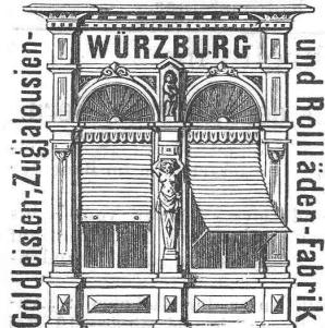
empfiehlt **Zugjalousien und Holzrolläden**, welche durch ihre vorzügliche Construction mit **Selbststeller, Bremse und Metallösenfassung** als das solideste und beste Fabrikat dieser Art von massgebender Seite anerkannt und ausgezeichnet sind, unter **Garantie** leichtester Handhabung und grösster Haltbarkeit.
