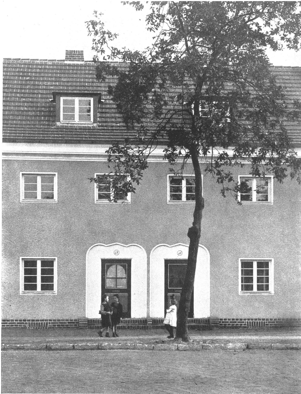
Siedlung Cöpenick — Normalhaustype III — Strassenansicht Architekt O. R. Salvisberg, Berlin
