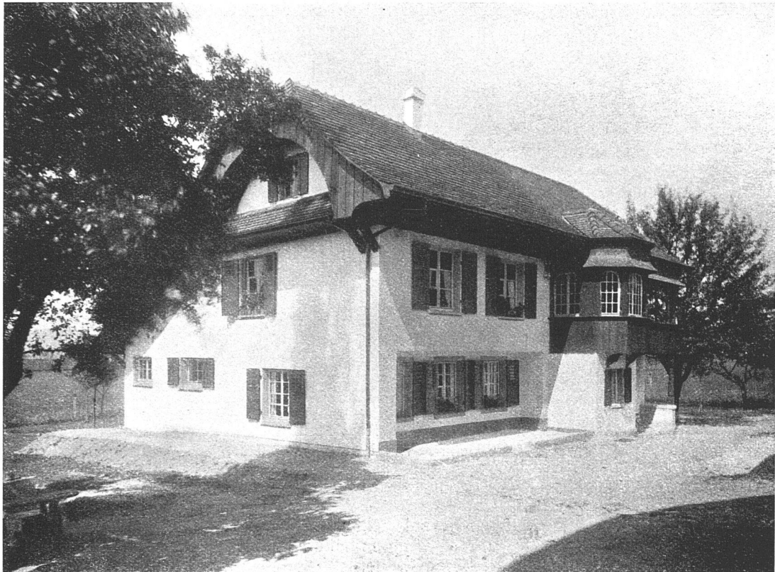
Haus Landwirt Märki (Umbau) Architekt: Heinrich A. Liebetrau, Rheinfelden
