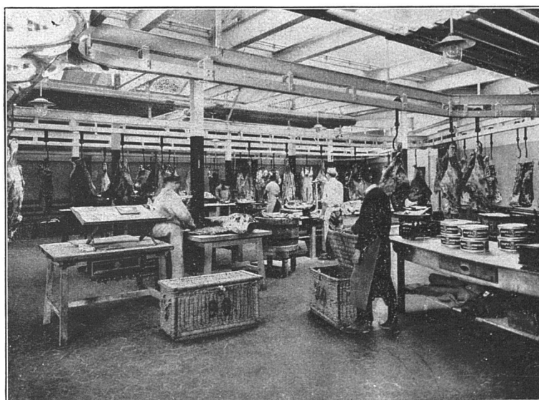
Das Kühlhaus der Bell A.-G. zu Basel.
