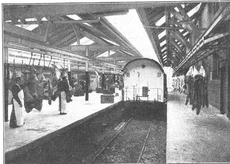
Das Kühlhaus der Bell A.-G. zu Basel.
