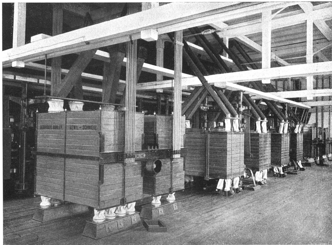
Mühlennneubau der Firma Steiners Söhne in Malters. — III. Stock: Plansichterboden. Architekt: Johann Bucher, Luzern.
