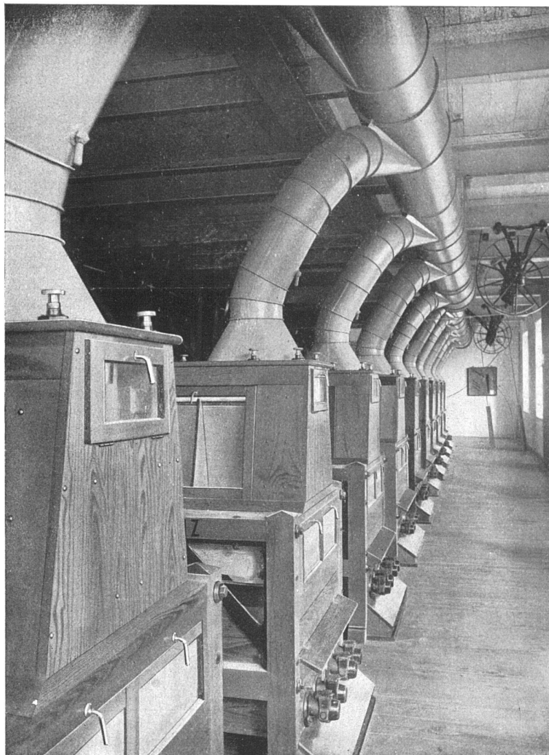
Mühlenneubau der Firma Steiners Söhne in Malters. — II. Stock: Boden der Griessputzmaschinen.
