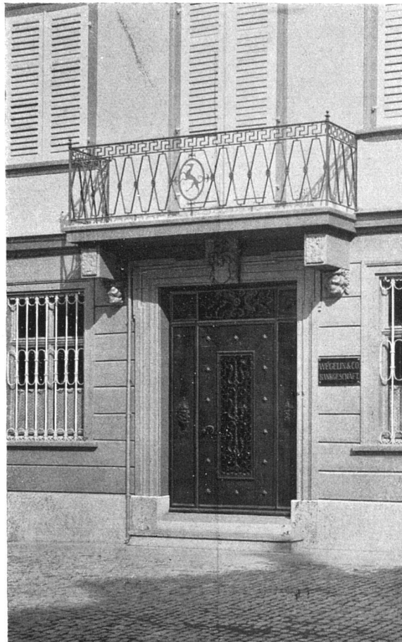
Bankhaus Wegelin & Co., zum Nothveststein, St. Gallen. Bankeingang. Steinere Türumrahmung alt, Kupfertüre und Balkon neu. Architekten: von Ziegler & Balmer, St. Gallen.
