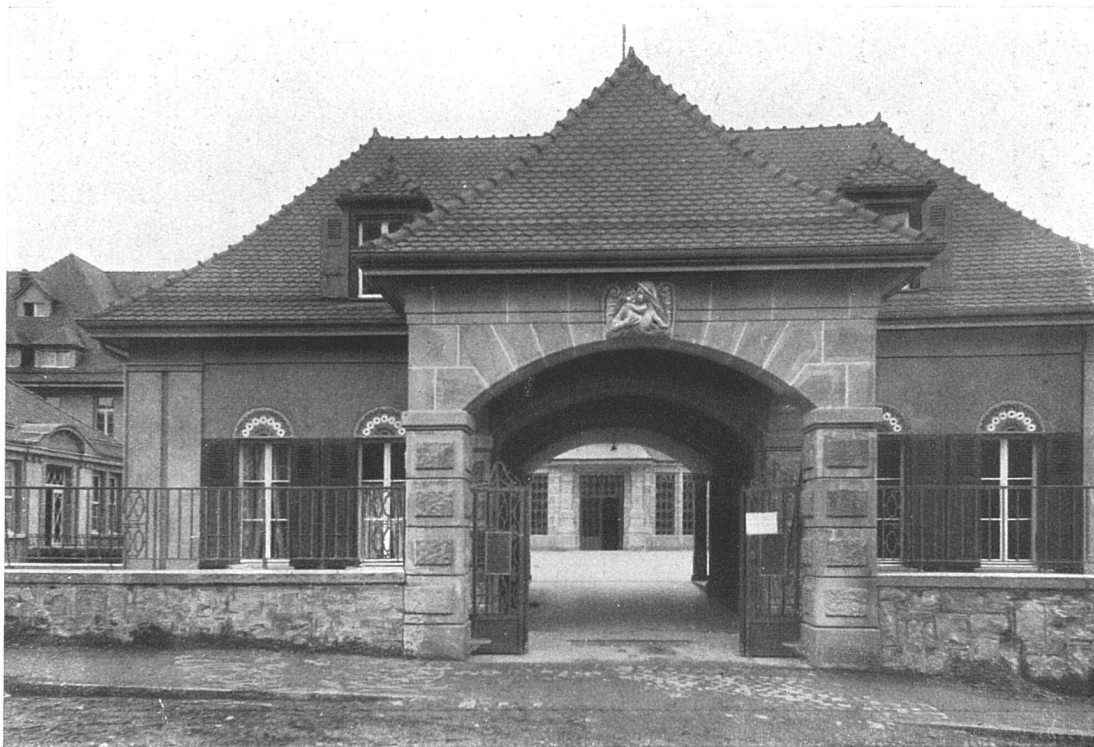
Tordurchgang und Haupteingang zur Frauenklinik in Lausanne. — Architekt G. Epitoux, Lausanne.
