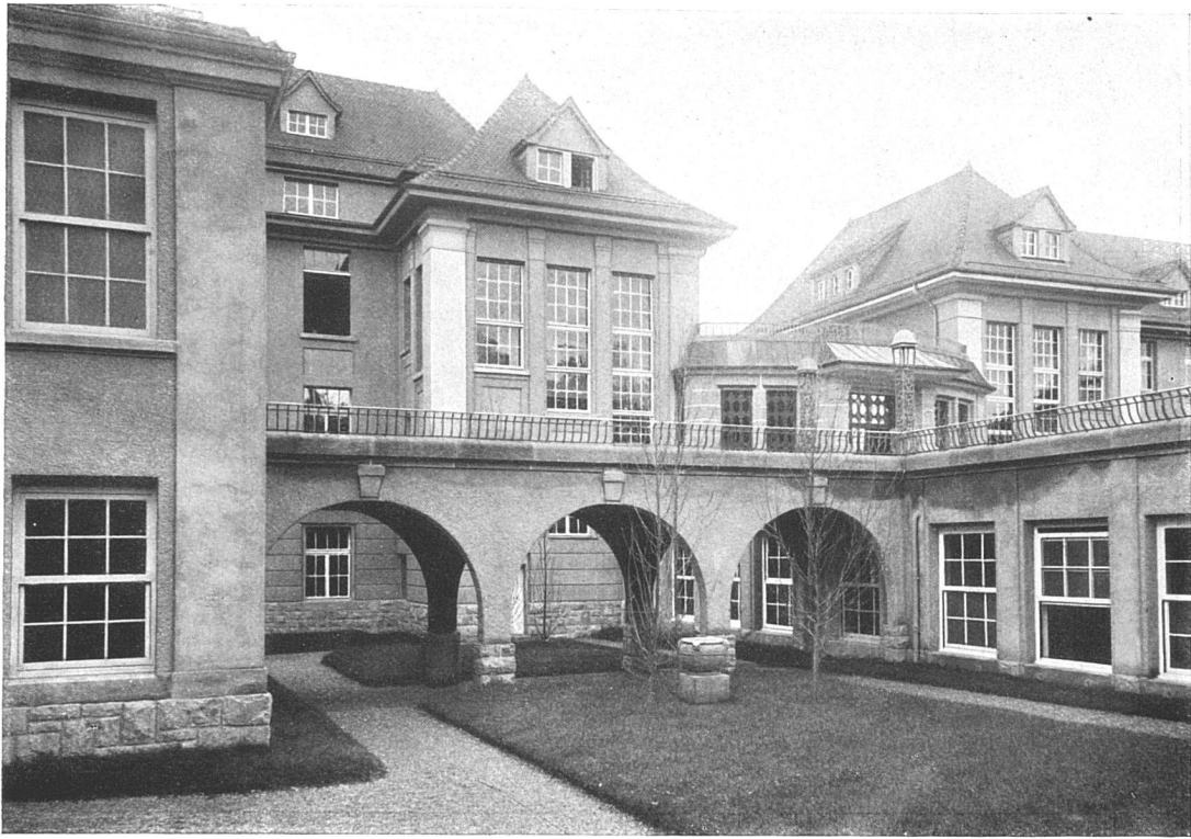
Der Hof der Frauenklinik in Lausanne. — Architekt G. Epitoux, Lausanne. Links der Hörsaal der Frauenklinik, in der Mitte die beiden Anstalten mit dem Haupteingang, rechts unten der Küchentrakt.
