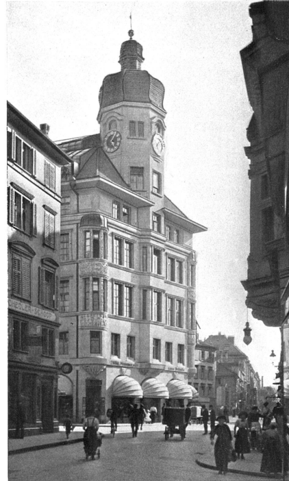
Das Haus zum «Rösslitor» in St. Gallen von der Multergasse aus
