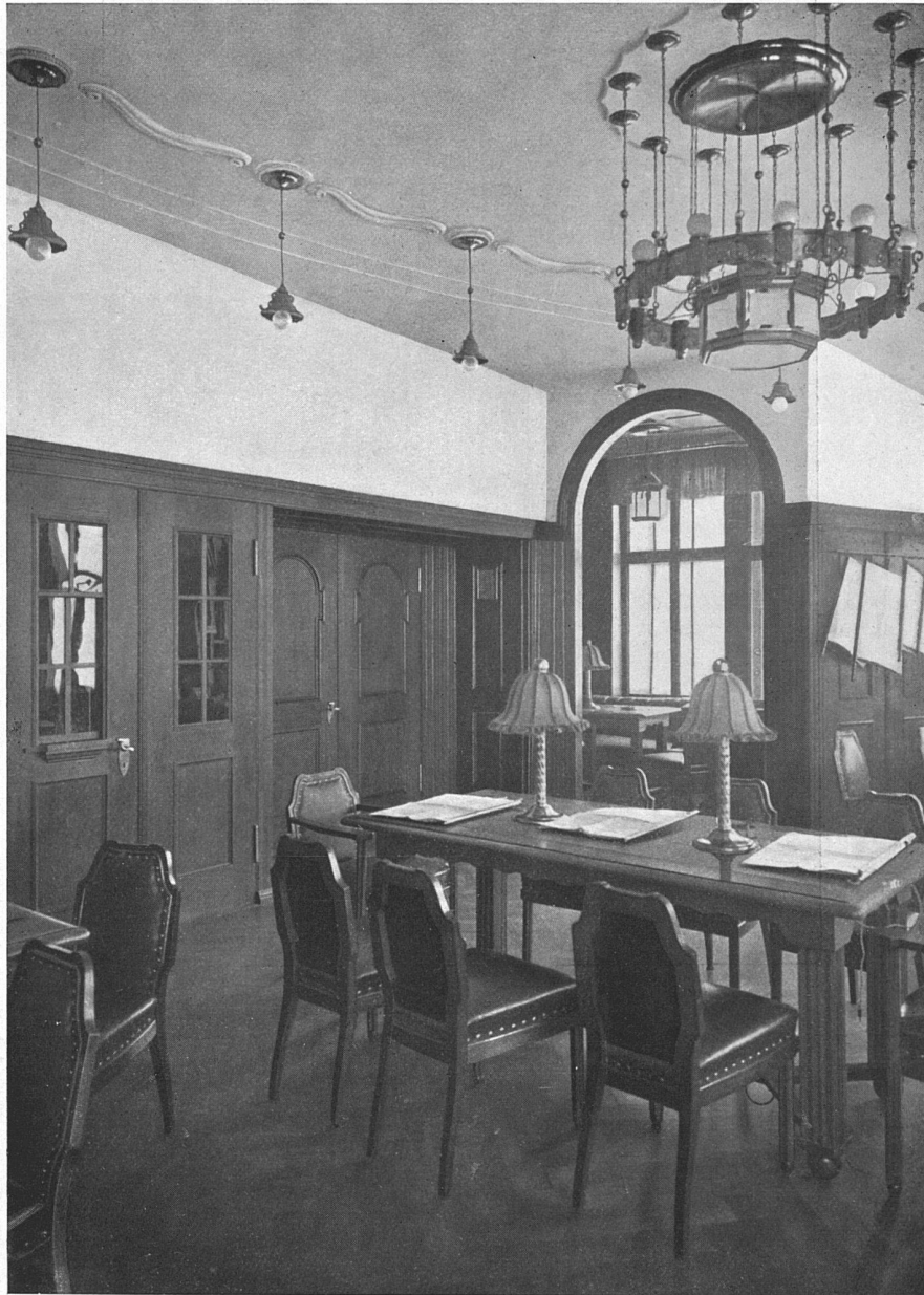
Das Haus zum «Rösslitor» der Museumsgesellschaft zu St. Gallen. Der grosse Lesesaal und Blick in die Sitznische. Architekten Höllmüller & Hänny, St. Gallen.
