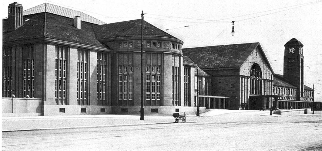
Das Aufnahmegebäude des badischen Bahnhofes zu Basel. Architekt Professor Karl Moser (Curjel & Moser), Karlsruhe.
