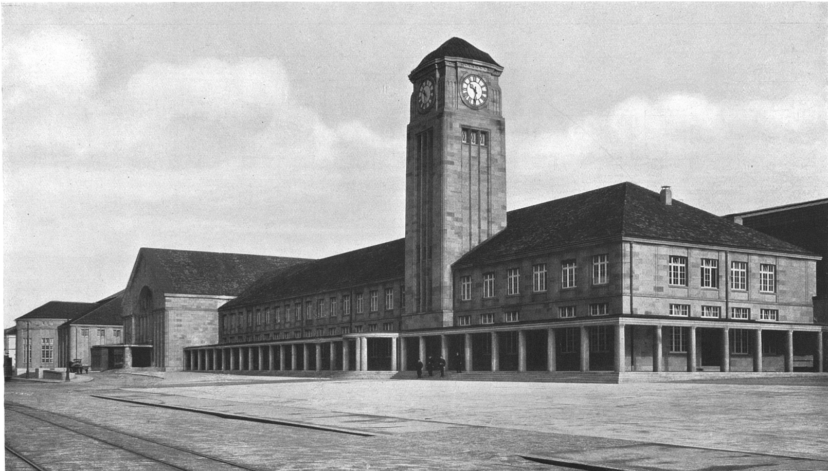
Das Aufnahmegebäude des badischen Bahnhofes zu Basel. — Die Gesamtansicht. Architekt Professor Karl Moser (Curjel & Moser), Karlsruhe.
