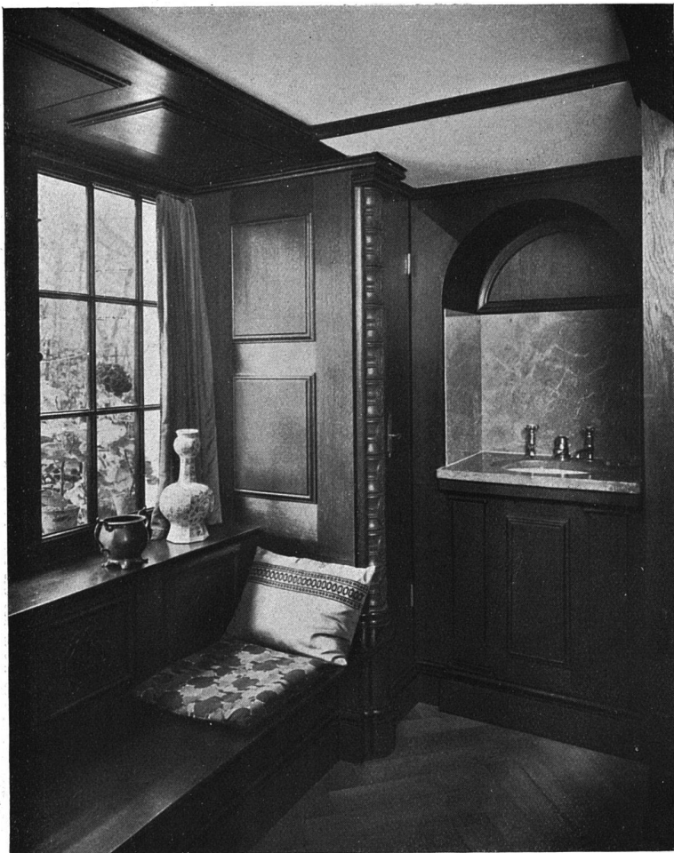
Einbau unter dem Treppenpodest der Halle und Kaminumbau im Esszimmer, beides in Eichenholz ausgeführt von der Schreinerei Brombeiss & Co., Zürich. Vom Umbau des Hauses des Herrn Moersdorff-Scherrer zu Zürich, Freiestrasse (1912). Architekt Otto Zollinger, Zürich 5, Zeltweg.
