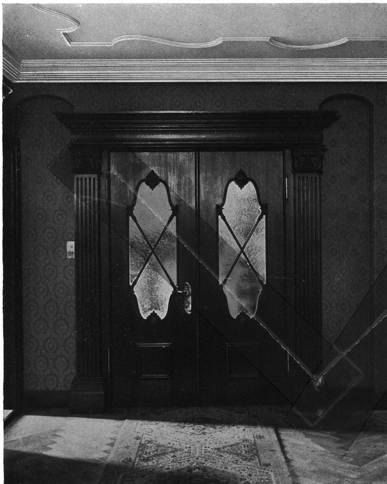
Eingang und Treppenpartie aus der Halle, ausgeführt in Eichenholz durch die Schreinerei Brombeiss & Co., Zürich. Vom Umbau des Hauses des Herrn Moersdorff-Scherrer zu Zürich, Freiestrasse (1912). Architekt Otto Zollinger, Zürich 5, Zeltweg.
