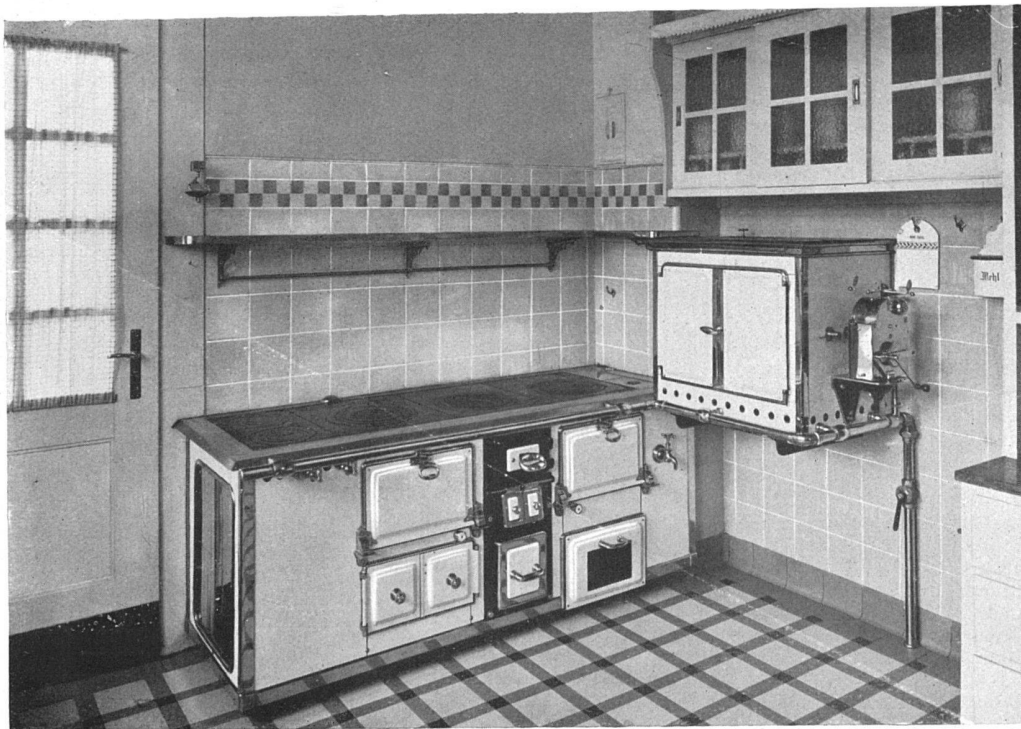
Aus der Küche des Herrn Hofmann in Zürich-Wollishofen. Senking-Herd für Kohle und Gas mit Schränken und Kohlenwagen, daneben Spiess- und Grill-Apparat für Gas.
