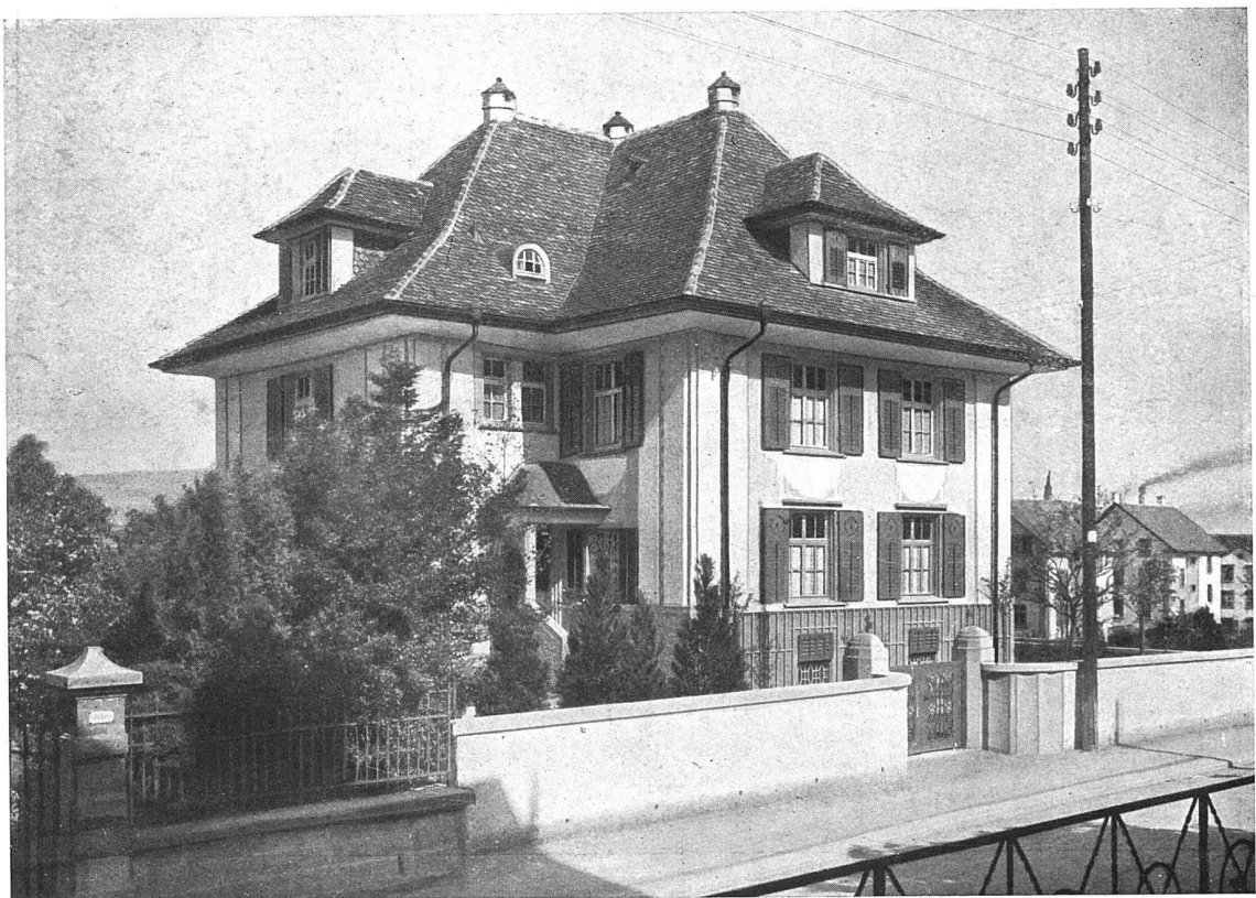
Landhaus Kölliker-Studer, Thalwil, Straßenseite. Architekt B. S. A. Heinrich Müller, Thalwil
