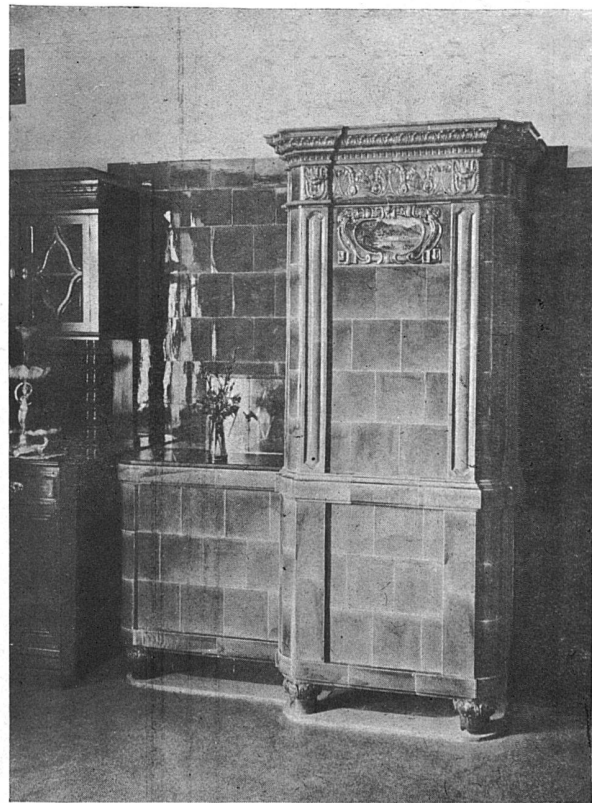
Ofen in der Villa Uttinger in Zug. — Architekten W. S. A. Keiser & Bracher in Zug. — Ausführung: Jos. Keiser, Hafnermeister in Zug
