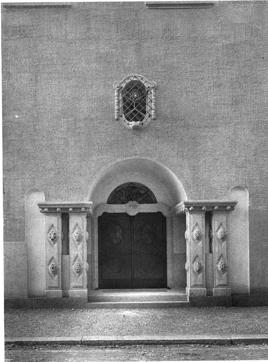
Portal an der Ausstellungsstraße Phot. Wolf-Vender, Zürich
