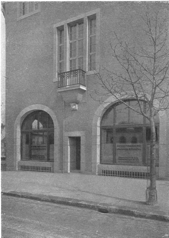
Linker Flügel gegen die Stauffacherstrasse
