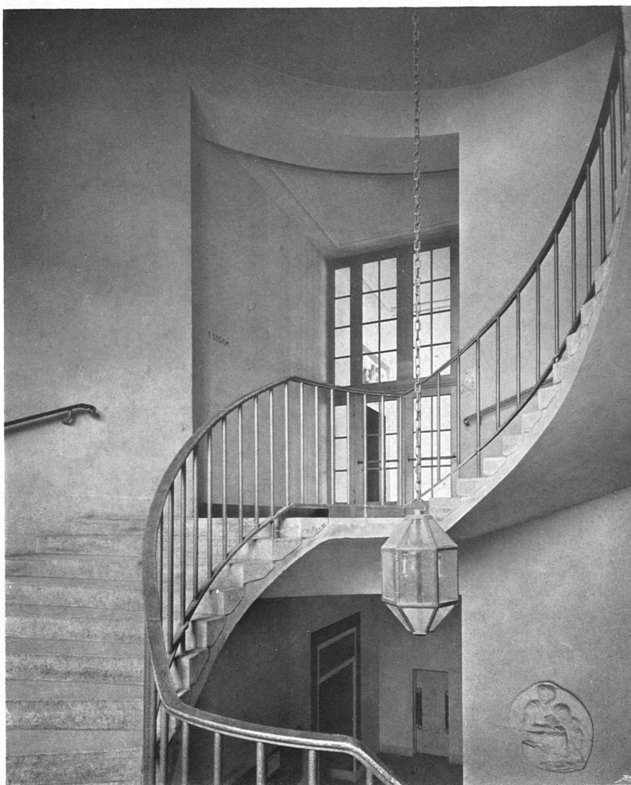
Doale Treppe im Turm Granitstufen auf armiertem Beton
