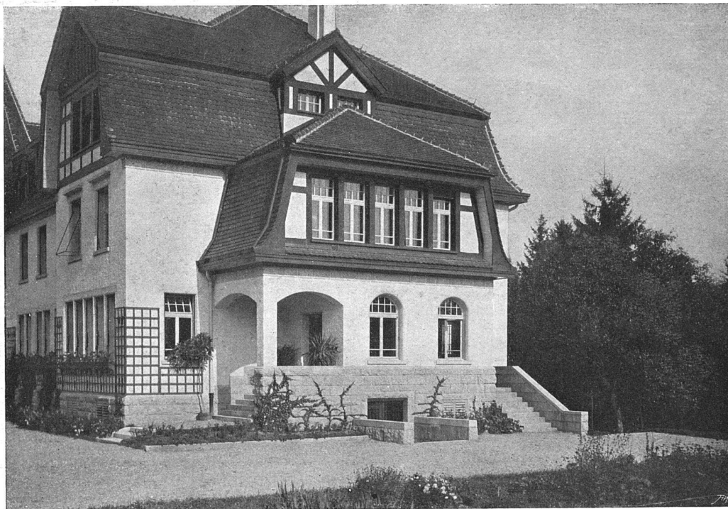
Ansicht der Südfassade
