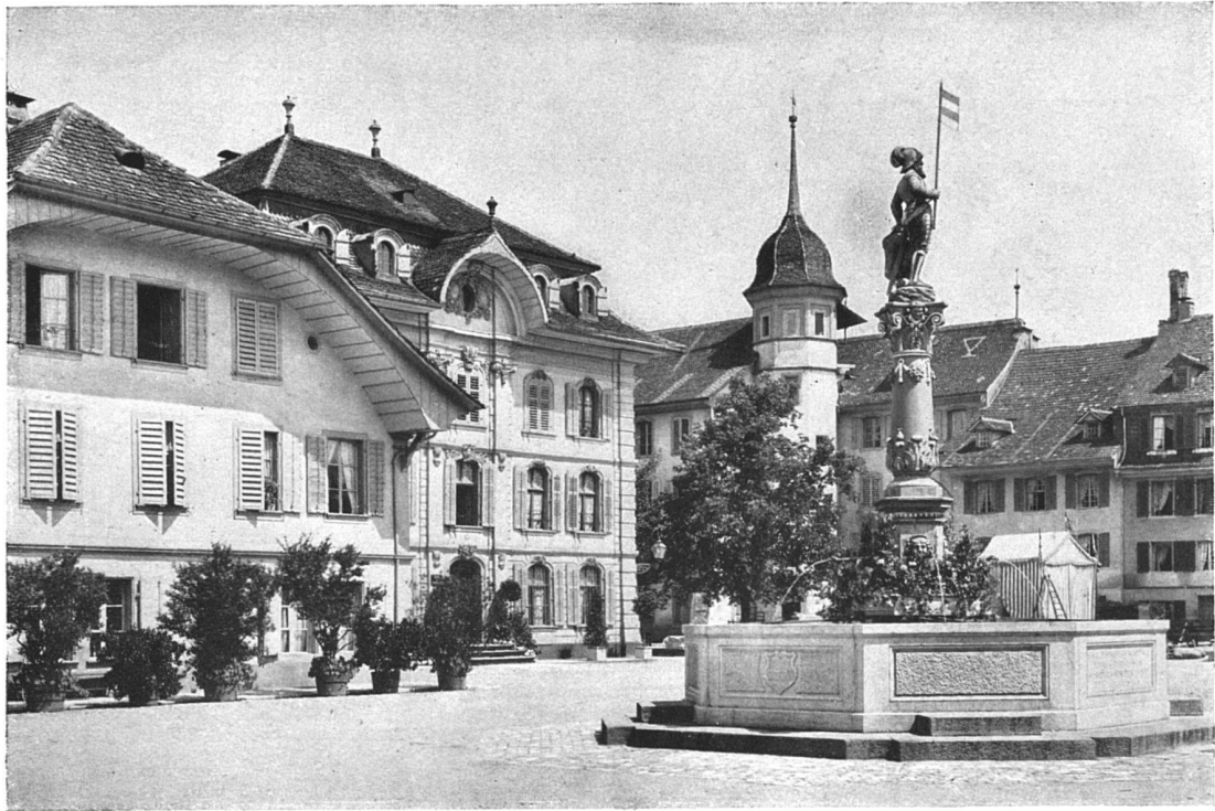
Ansicht des Niklaus Thut-Platzes in Zofingen gegen Bank und altes Schulhaus Aufnahme von Ph. & C. Lint, Zürich
