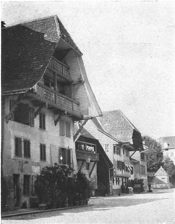
Das Haus „zum großen Mohren“ in Zofingen
