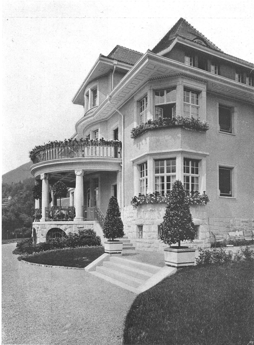
Ansicht der Südost-Ecke
