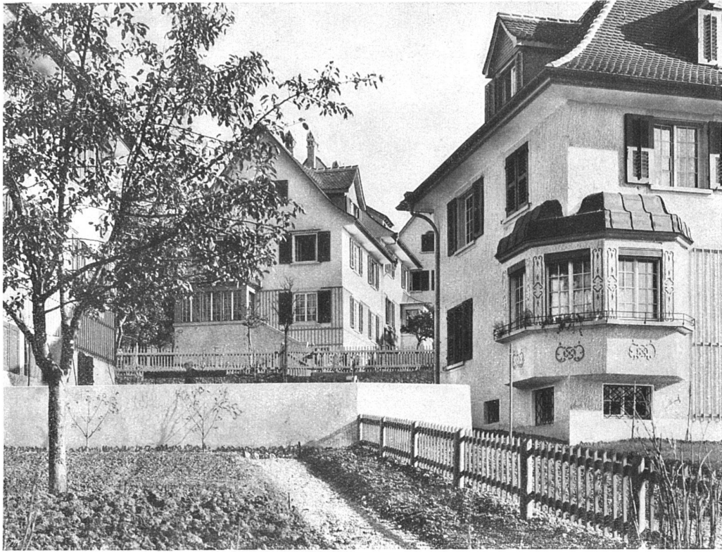
Blick von der projektierten Straße B. nach Osten
