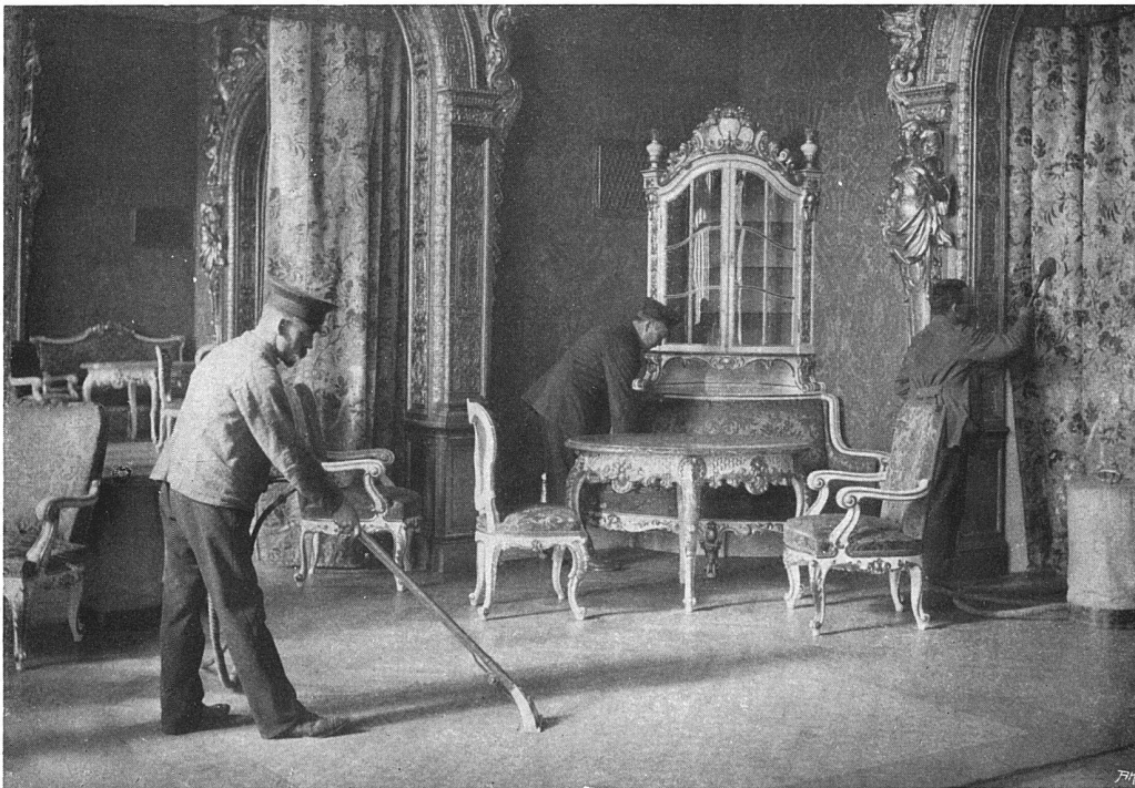
Handhabung der Möbel-Staubsauger (D. R. P.) des Systems A. Vorsig, Berlin und Tegel Vertreter für die Schweiz Wanger & Huber, Zürich III
