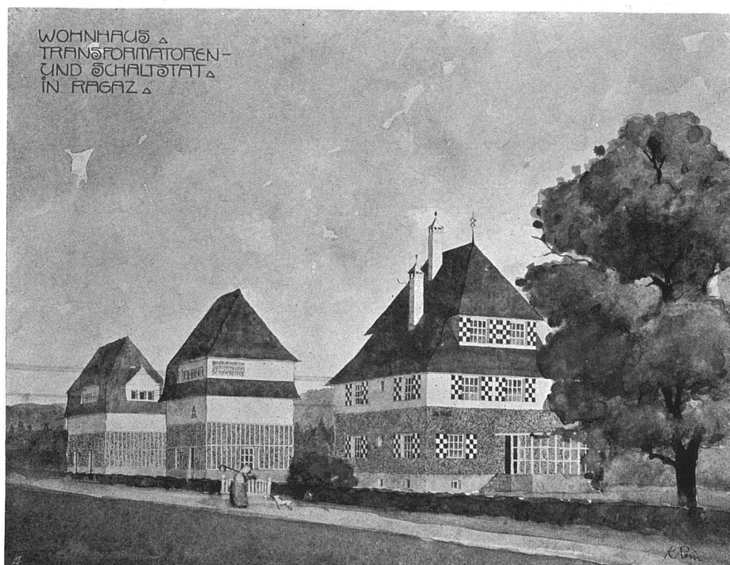
Wärterwohnhaus, Transformator- und Schaltstation in Ragaz
