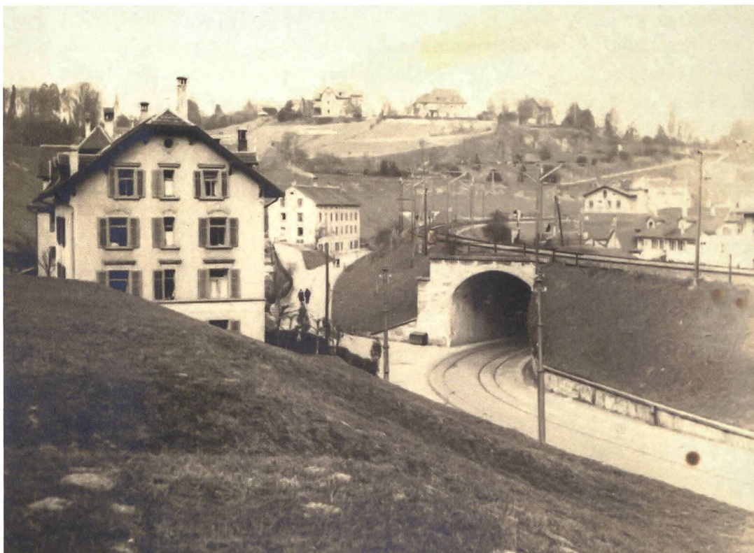
7 Die SBB-Unterführung am Fuss der Katzensteig, Blick von Neuhausen her; links das Haus «Neue Heimat» am Eingang des Bahntals [1939]. Staatsarchiv Schaffhausen, Justiz 41/1.6.
