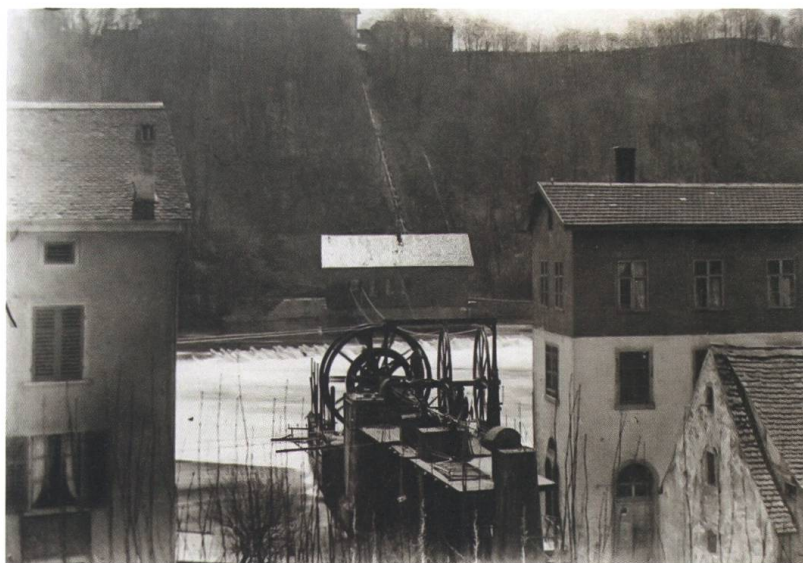
4 Pfeiler 1 Centrale A der Wasserwerks-Gesellschaft mit Transmissionswelle zur Schweizerischen Bindfadenfabrik Flurlingen, 1880. Stadtarchiv Schaffhausen, J 02.01.113/020.
