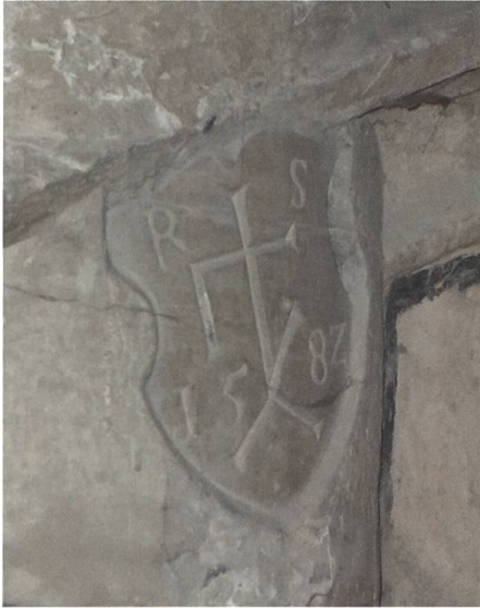
2 Steinmetzzeichen des neu entdeckten zweiten Werkmeisters am Munot, Rudolf Schertzinger, am Ende der Reitschnecke im Turm, 1582. Foto: Kurt Bächteli.
