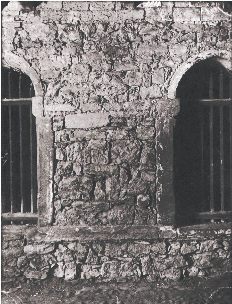
6 Allerheiligen, Kreuzgang, Ostflügel. Wandpfeiler während der Renovierung von 1902, nach der Entfernung des Verputzes. Die durchlaufende Sandsteinbank belegt, dass an dieser Stelle ebenfalls eine Arkade bestand. Datiert 1902. Eidgenössisches Archiv für Denkmalpflege, Bern: Schaffhausen, Kloster Allerheiligen, Kreuzgang, Nr. 3430.
