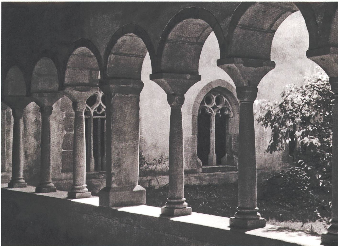
8 Allerheiligen, Kreuzgang, Ostflügel. Die ursprünglichen romanischen Säulenarkaden, gruppiert durch einen schlanken Zwischenpfeiler. Foto nach 1910. Stadtarchiv Schaffhausen, J 02.20.04_08.
