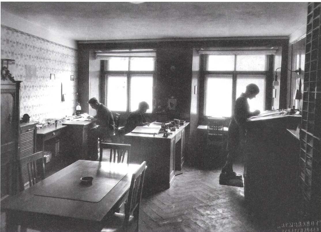
15 Das Büro der Administration 1929. Foto: Rembrandt, Schaffhausen.
