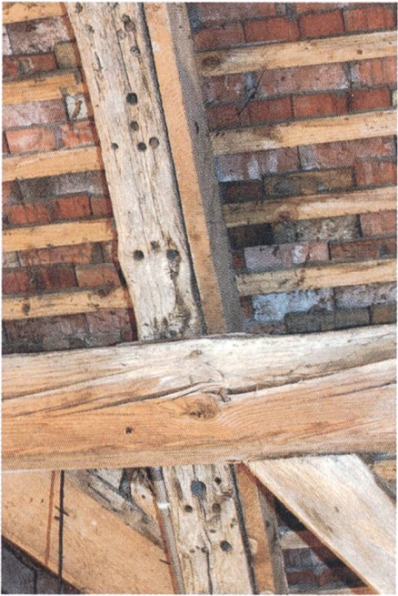
Abb. 4: Unterseite der wiederverwendeten, im heutigen Dach verbauten Sparren.
