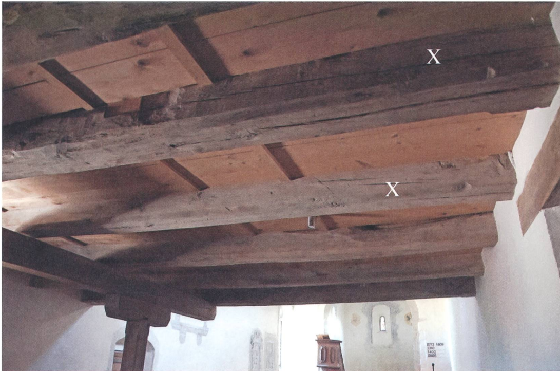
Abb. 26: Deutlich sichtbar der unterschiedliche Fasenauslauf der Emporenbalken von 1487/88 (x) bzw. der Emporenverlängerung gegen Osten von 1751.
