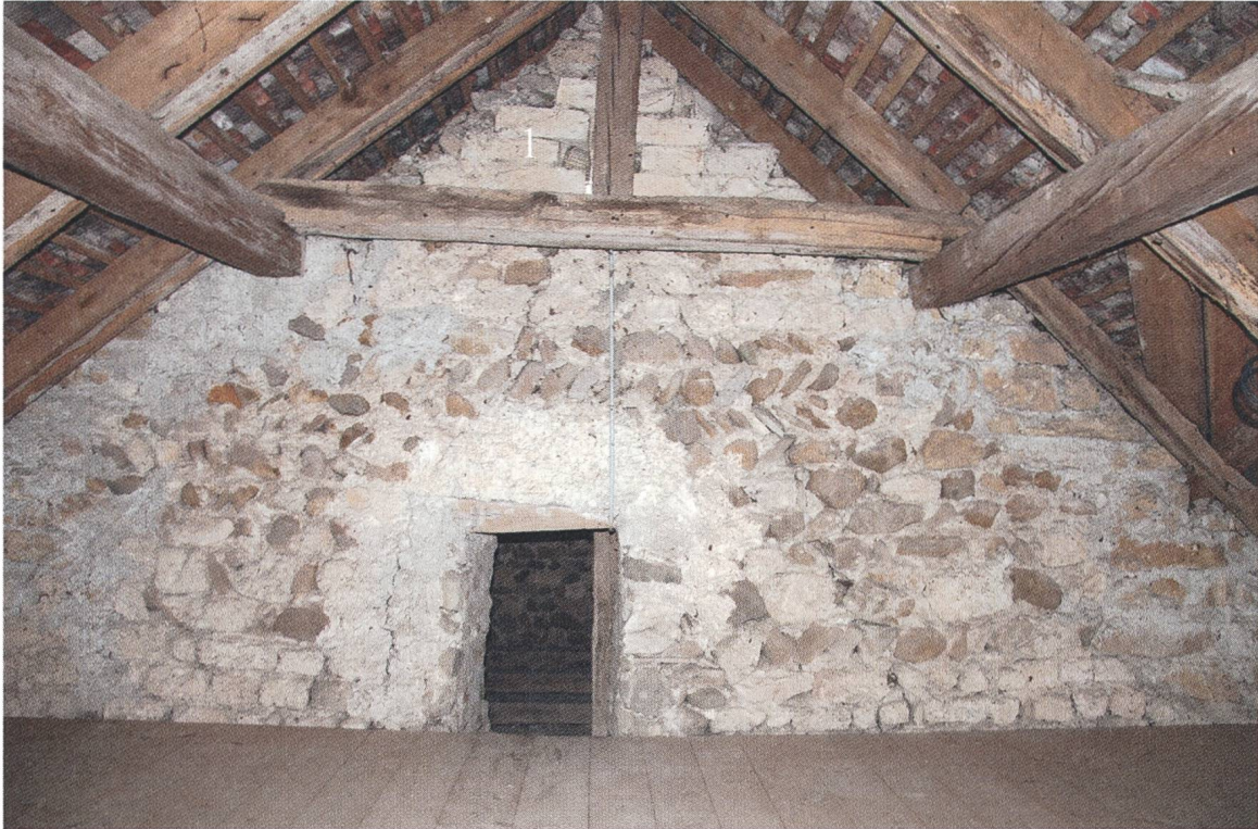
Abb. 13: Giebelwand im Dachraum über dem Chorbogen, um 1150, mit einzelnen Steinlagen schräggestellt in der Art des opus spicatum und Kreuzschlitz aus Kalksteinen (1), im Dachstuhl von 1637.
