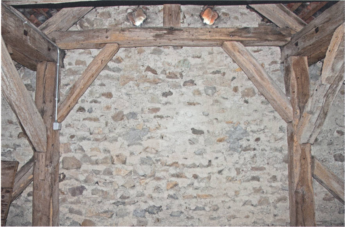
Abb. 43: Giebelwestwand mit Abdrücken der Schalbretter und Dachstuhl von 1688.
