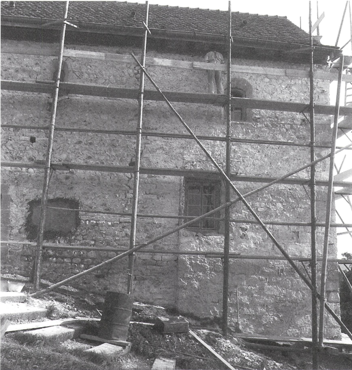
Abb. 42: Schiffnordwand, Westabschnitt von 1487/1688 mit Vertikalfuge, nach Putzentfernung im Juli 1953.
