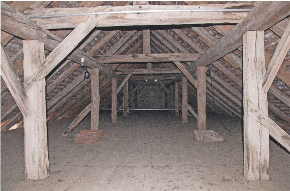
Abb. 38: Dachstuhl von 1637 mit viel Altholz über dem romanischen Schiffteil, Blick Richtung Westen.
