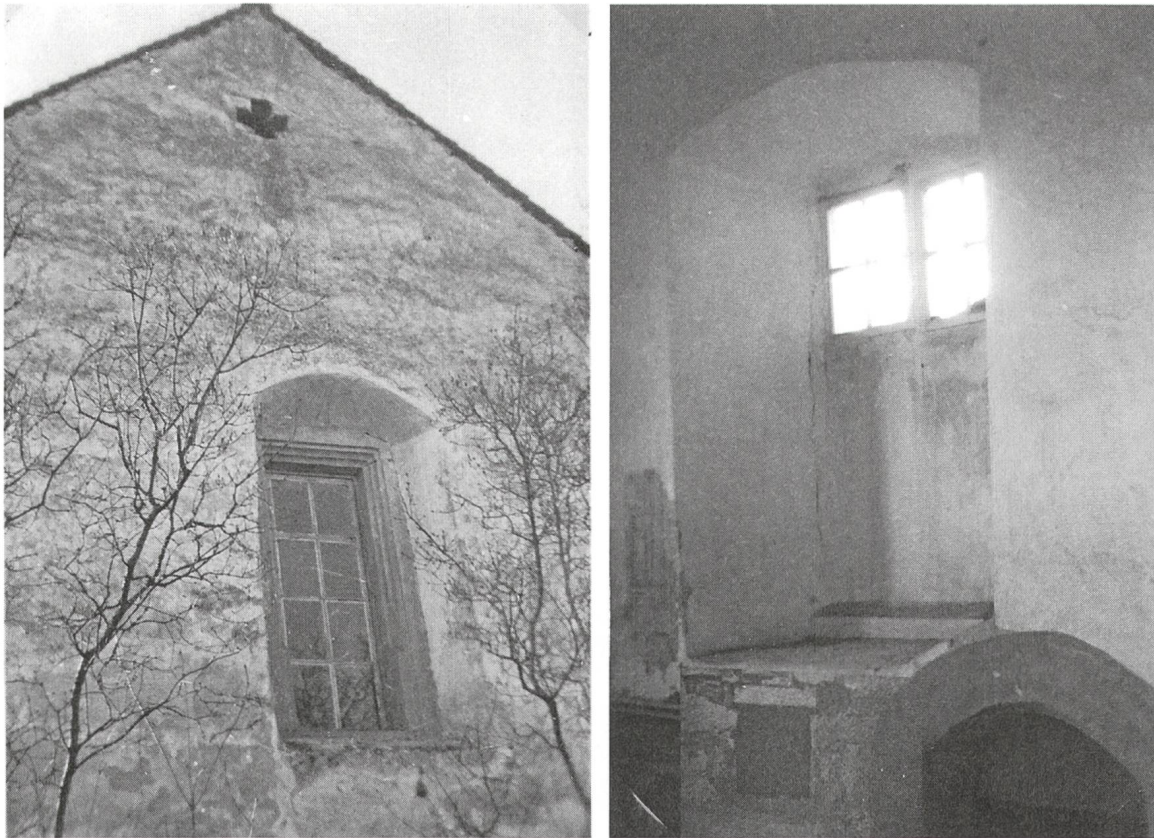
Abb. 30: Chorostwand mit spätgotischem Fenster von 1487/88, darüber romanischer Kreuzschlitz, um 1150, aufgenommen vor der Renovation von 1953 (vgl. Abb. 8).
