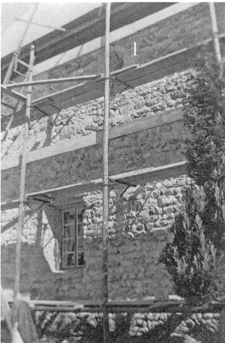
Abb. 10: Schiff, Nordostecke, um 1150, Eckquadern aus Kalksteinen, nach Putzentfernung im Juli 1953.
