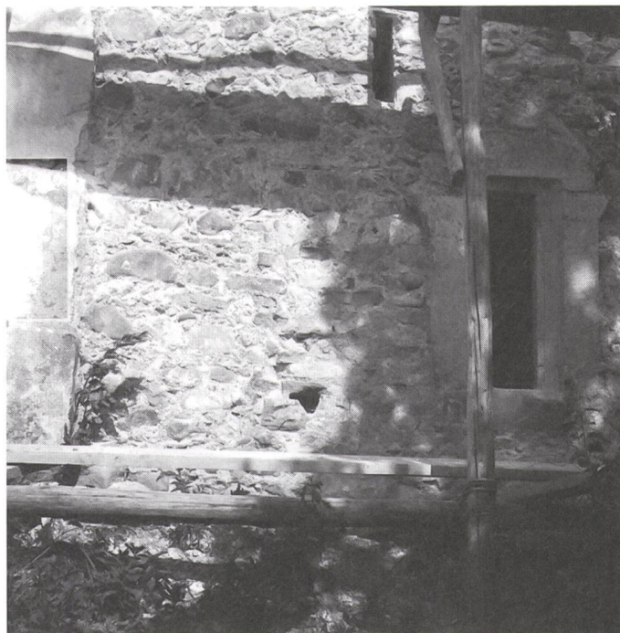
Abb. 29: Detail des Mauerwerks der spätgotischen Sakristei mit Rechteckfenster, Auslauf der Piscina und Belüftungsscharte, nach Putzentfernung im Juli 1953.
