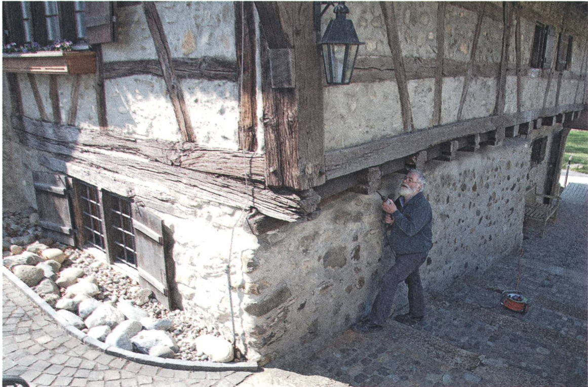
Abb. 35: Mesmerhaus von Südosten. Das Fachwerk datiert von 1501, während die Stube in der Ecke im späten 17. Jahrhundert ersetzt wurde. Bauforscher Burghard Lohrum bei der Entnahme der Bohrproben (vgl. Abb. 34).
