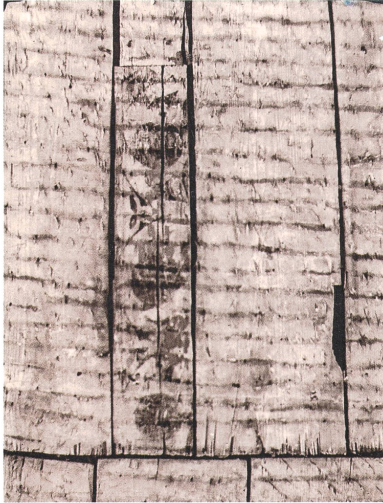
Abb. 53: Unter der heutigen, romanisch anmutenden Holzdecke von 1953 liegt die Bretterunterlage der Gipsdecke von 1751, für welche Teile der gotischen Holzdecke von 1487/88 verwendet wurden (vgl. Abb. 32).
