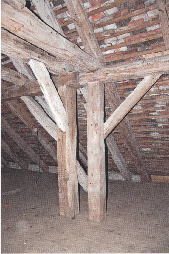
Abb. 39: Dachstuhl von 1637 über dem romanischen Schiffteil (links) beim Übergang zum Dachstuhl über der Schiffverlängerung von 1688 (rechts).
