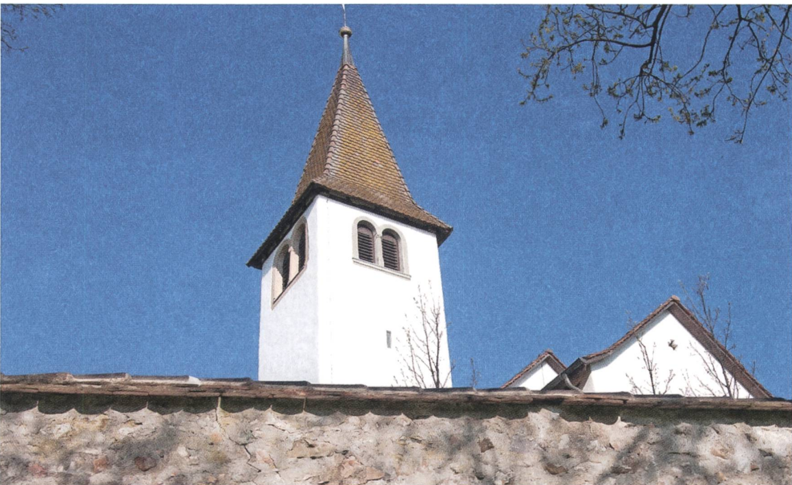
Abb. 50: Die aus dem Turm des späten 13. Jahrhunderts übernommene romanische Schallöffnung aus Randengrobkalk (vgl. Abb. 22) diente als Vorlage für die übrigen Öffnungen im Glockengeschoss von 1702 (vgl. Abb. 48). Diese sind etwas kleiner und bestehen aus graugrünem Sandstein. Mit dieser Nachbildung sollte wohl das hohe Alter des Bauwerks betont werden.
