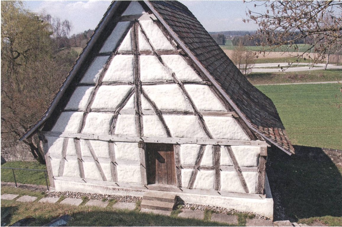
Abb. 37: Südfassade der Scheune von 1583. Das Obergeschoss ist vom Hang her zugänglich.
