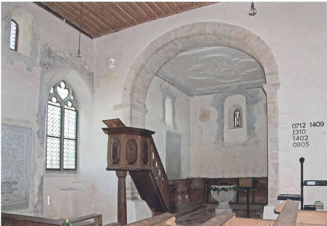
Abb. 27: Der Chorbogen stammt aus der Bauzeit um 1150, das spätgotische Masswerkfenster mit stehender Fischblase von 1487/88. Letzteres wurde eingebaut zur besseren Belichtung der Kanzel und der Kirchenstühle der Vogtsfamilie. Darunter in der Fensternische die Stufenreste der mittelalterlichen Kanzel (1), die Kanzel von 1721 und darüber schwach zu erkennen das Im Thurn-Wappen (2).
