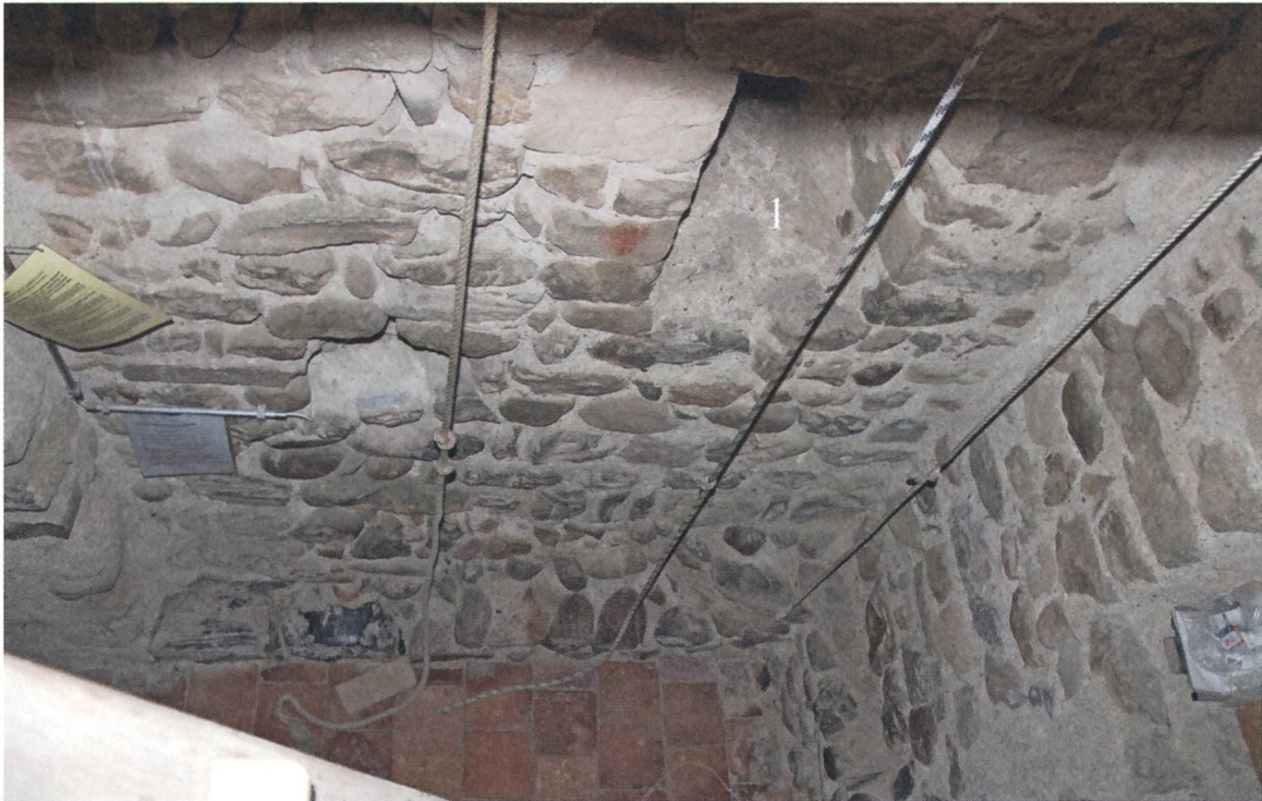
Abb. 21: Sockelgeschoss des Turms aus dem späten 13. Jahrhundert, mit dem durch die Sakristei verbauten Ostfenster (1).
