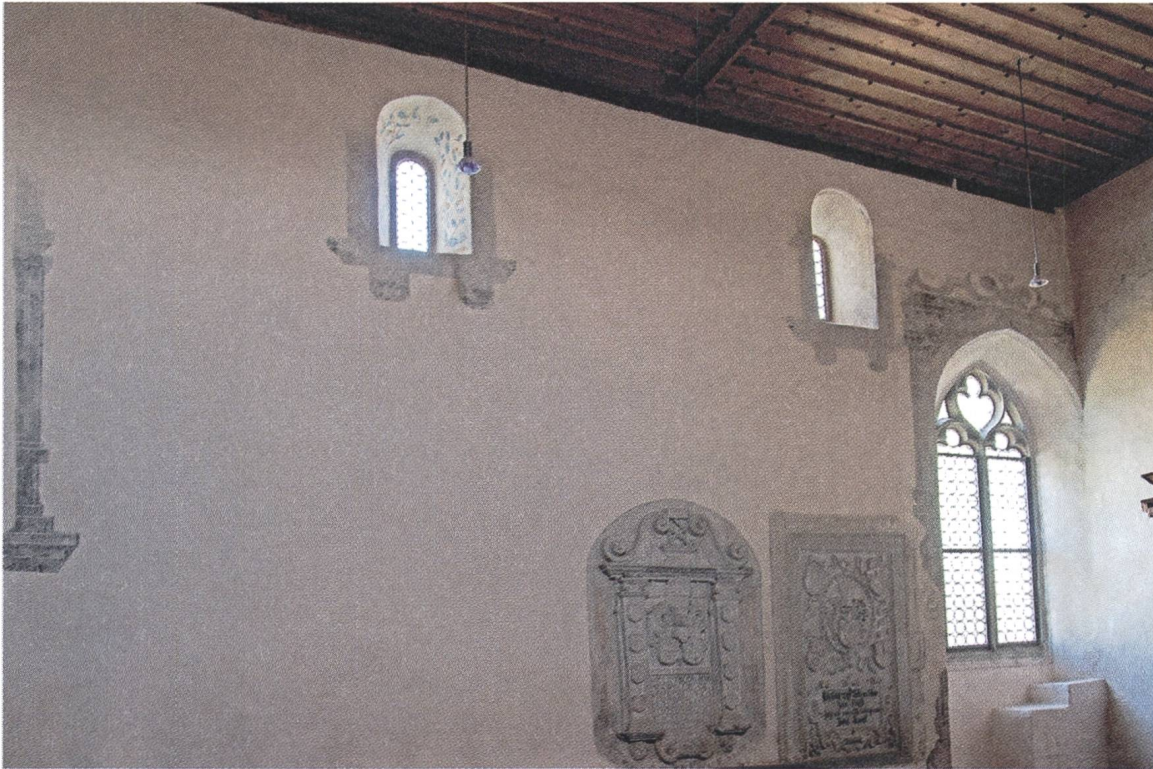
Abb. 15: Schiffnordwand, romanische Fenster, um 1150, mit spätgotischer Rankenmalerei in der Leibung sowie Grisaillemalerei von 1637/88. Rechts davon Masswerkfenster und Treppenstufen zur Kanzel von 1487/88.
