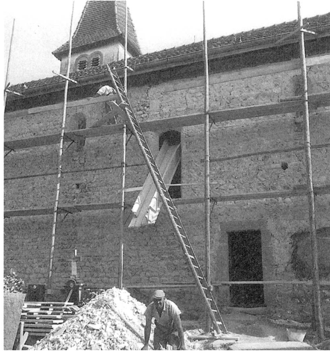
Abb. 10: Schiff, Nordostecke, um 1150, Eckquadern aus Kalksteinen, nach Putzentfernung im Juli 1953.
