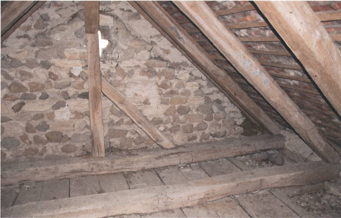
Abb. 23: Handgespaltene Bohlenbretter von 1273 im Chordachstuhl von 1738.
