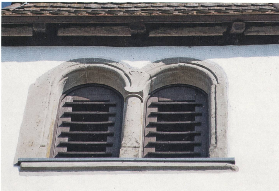
▼ Abb. 48: Schallöffnung aus Sandstein im Glockengeschoss (Westfassade) des Turms von 1702. In den Bögen eingemeisselte Inschrift: Kirchenpfleger Bartholomäus von Ow aus Büsingen, Hans Mezger aus Buchthalen, in der Mitte die Jahreszahl 1702.
