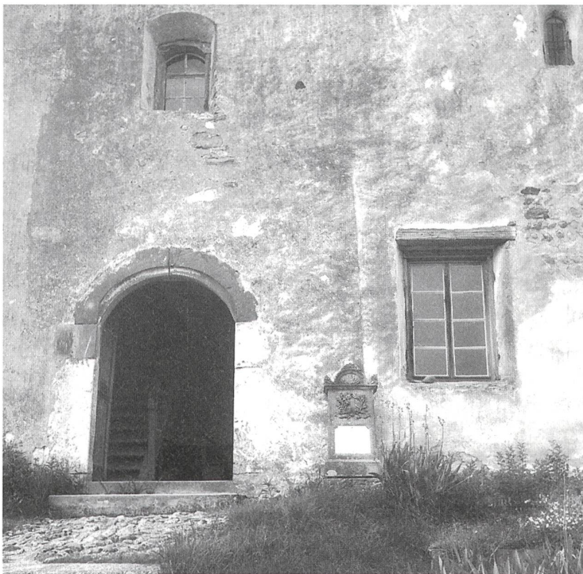
Abb. 44: Südeingang der Kirche aus Sand- und Kalkstein von 1688, 1953 ersetzt (vgl. Abb. 41).
