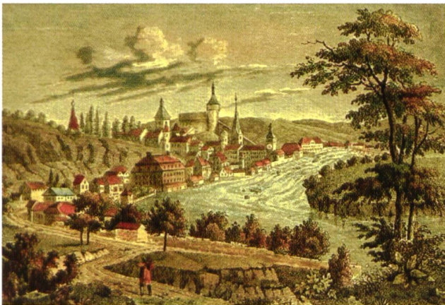
Auf dieser Ansicht von Westen sind die „Lächen“, welche die Weiterfahrt der Schiffe bereits vor dem Rheinfall verhinderten, deutlich zu sehen (Johann Conrad Friedrich, um 1835)
