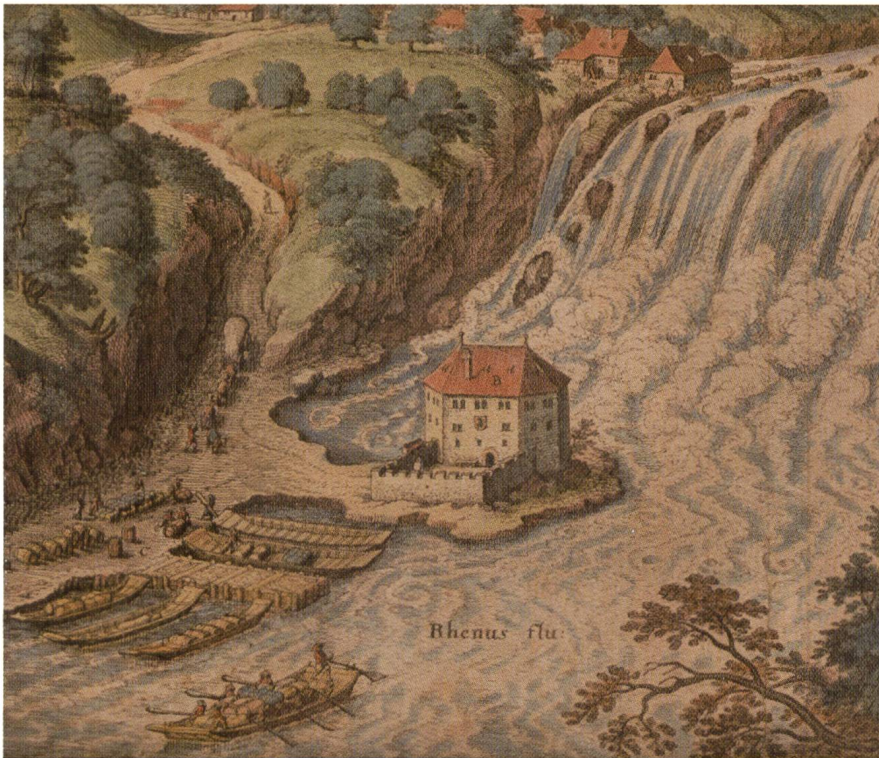
Salztransport auf der „Scheibengasse“ und Verlad im Hafen bei der Niederlage und Zollstelle „Schlössli Wörth“ (Merian)
