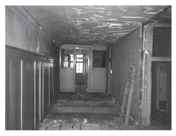
Abb. 9: Der Festsaal der «Schneiderstube» nach partieller Entfernung der Binnenwände, 1983. (Archivfoto Peter Rietschin)
