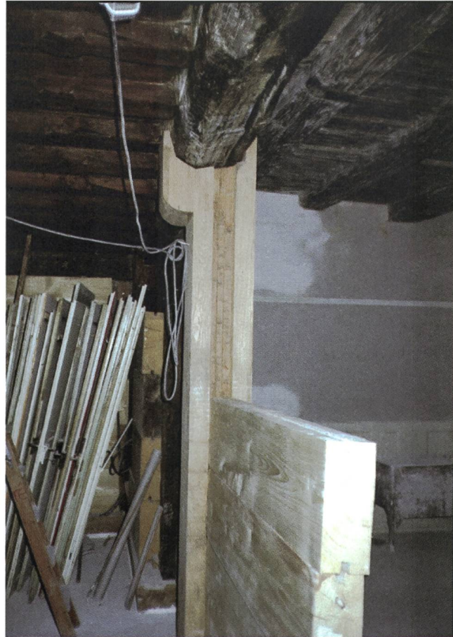
Abb. 7: Ergänzungsarbeiten in der gotischen Trinkstube der «Schneiderstube». Neuer Ständer mit nach originaler Methode eingeschobenen handgearbeiteten Bohlen, 1983. (Archivfoto Peter Rietschin)
