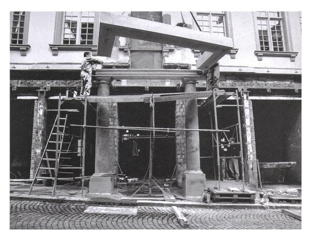
Abb. 14: Die Wiederinstandsetzung des Portikus mit säulengetragenem Balkon am «Rüden». (Archivfoto Christine Aries-Keller)
