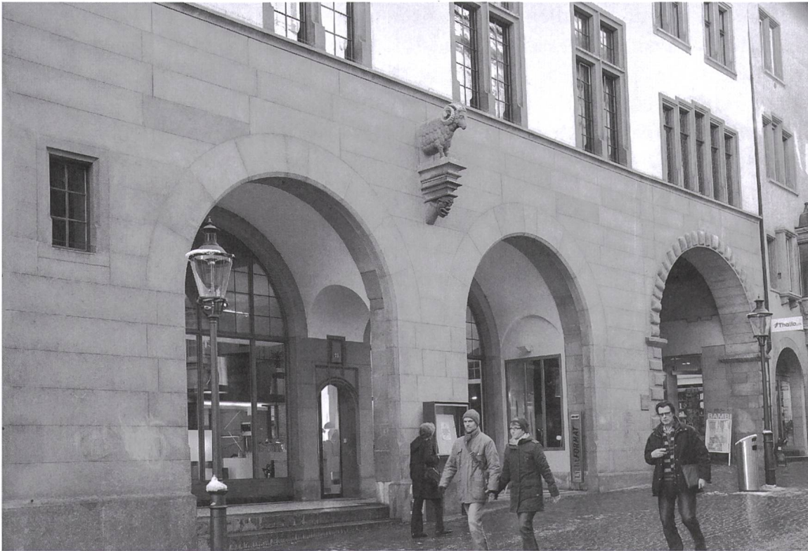
Abb. 8: Repräsentative, dem Kaufhaus (heute Rathaus) 1409 vorgeblendete Sandsteinfassade mit dem Schaffhauser Bock im Zentrum. Die vertikale Baufuge von 1412/13 zum Nüw Hus, dem Haus über dem Bogen, markiert den jüngsten Bauabschnitt des Rathauses. (Kantonsarchäologie Schaffhausen)
