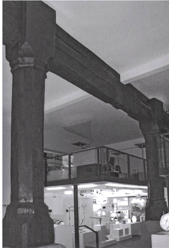
Abb. 7: Wie bei einer Kirche teilen die mächtigen, achteckigen Eichensäulen mit Unterzug und Sandsteinsockeln das Kaufhaus von 1395 in zwei Schiffe (heute: EKS Laden). (Kantonsarchäologie Schaffhausen)
