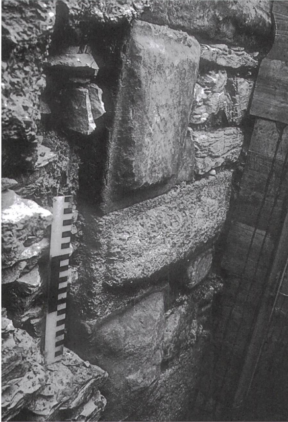
Abb. 14: Buckelquaderverband der Zeit um 1230 am alten Turm in der Neustadt. Als Steinmaterial fanden sowohl der poröse, gelbliche Randengrobkalk aus Uttenhofen bei Wiechs als auch der grüne Sandstein von Rorschach Verwendung. (Kantonsarchäologie Schaffhausen)
