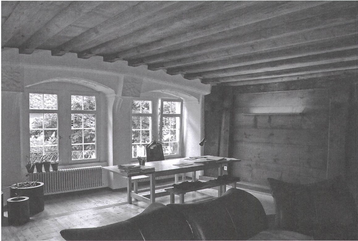
Abb. 5: Die alte Ratsstube von 1343, eine Bohlenstube mit leicht gewölbter Bohlen-Bälkchen-Decke im ersten Obergeschoss der Schneiderstube. (Kantonsarchäologie Schaffhausen)
