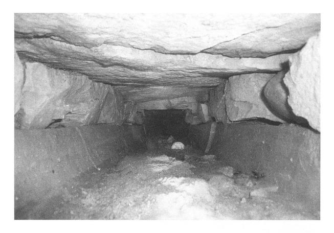
Abb. 4: Blick in die älteste mittelalterliche Wasserleitung der Schweiz aus dem 12. Jahrhundert am Fronwagplatz.
