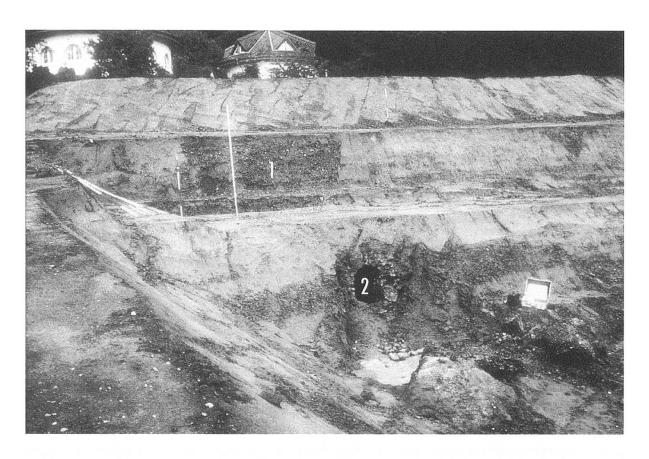
Abb. 8: Deutlich sichtbar im modernen Baugrubenprofil der mit Sickerkies aufgefüllte Grabeneinschnitt (1) über dem Sickerstollen (2) im Sandacker.
