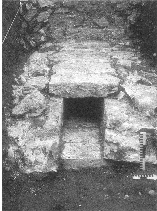
Abb. 15: Flach gedeckter Abwasserkanal von 1856/57 im Rüdenareal.
