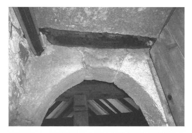
Abb. 8: Türe vom Schiffdachstuhl in den Turm mit angekohltem Holzbalken aus der Zeit um 1270.
