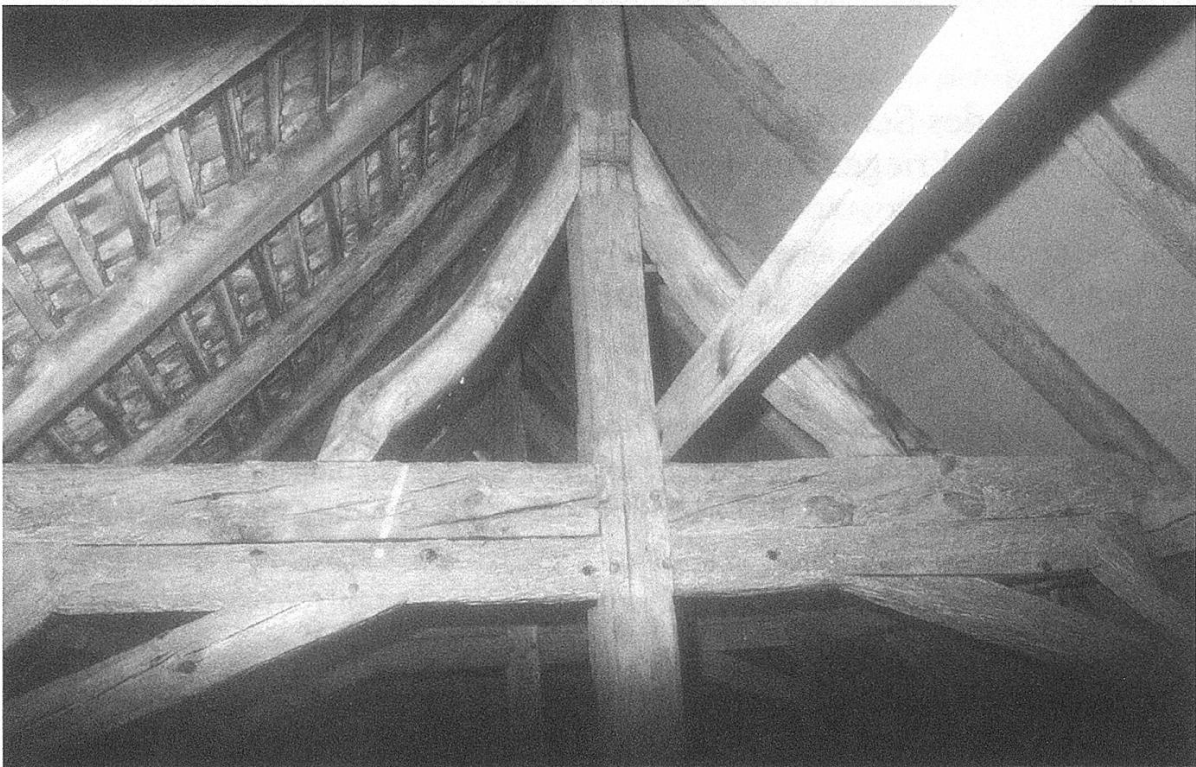
Abb. 11: Blick in den letztmals 1690 umgebauten Dachstuhl des Kirchenschiffes. Damals wurden Föhrenhölzer anstelle älterer Eichenhölzer eingesetzt. Von 1515 stammen unter anderem die Hängesäulen mit den charakteristischen, verdickten Knotenpunkten. Noch älter sind wiederverwendete Hölzer von 1306, 1412 und 1421.
