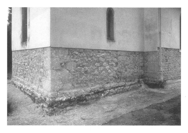
Abb. 6: Umlaufender Sockel des Chorturms und lanzettförmiges Nordfenster aus Randengrobkalk mit modern vermauerter Türe zur ehemaligen Sakristei um 1270.
