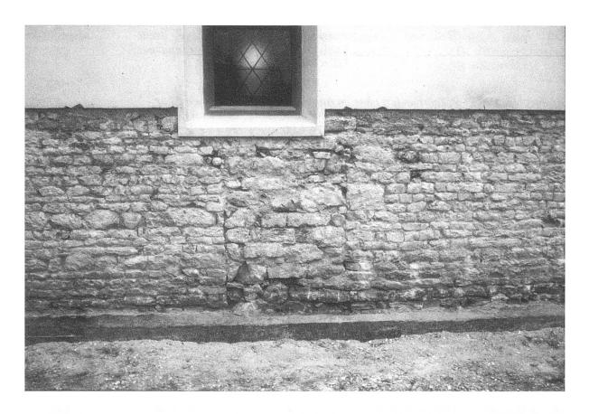
Abb. 2: Nordseitiges Mauerwerk des Kirchenschiffs aus dem 11. Jahrhundert im Bereich des ehemaligen Eingangsportals. Es besteht aus lagerhaft verlegten Handquadern aus Kalk, auf Sicht gemauert mit Resten von Fugenstrich.
