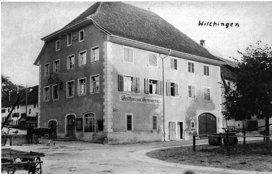
Der 1822 an der Stelle des alten Gemeindehauses entstandene Neubau im ursprünglichen Zustand. (Ansichtskarte um 1929)
