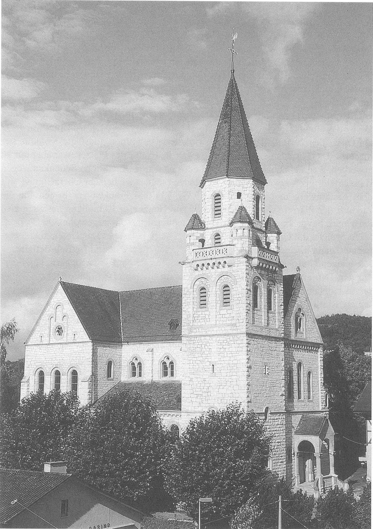
Die in Bossenmauerwerk aus Jurakalkstein erbaute neuromanische Heilig Kreuz-Kirche in Neuhausen nach der Restauration 1991/93. (Bild: Fotograf Ernst Müller, Neuhausen am Rheinfeld, 1993)
