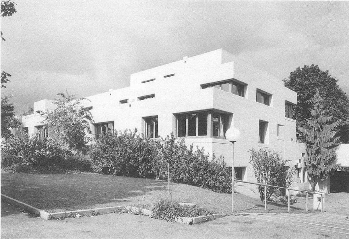
Ansicht des Pfarreizentrums St. Konrad. (Bild: Kath. Pfarramt St. Konrad, 1999)
