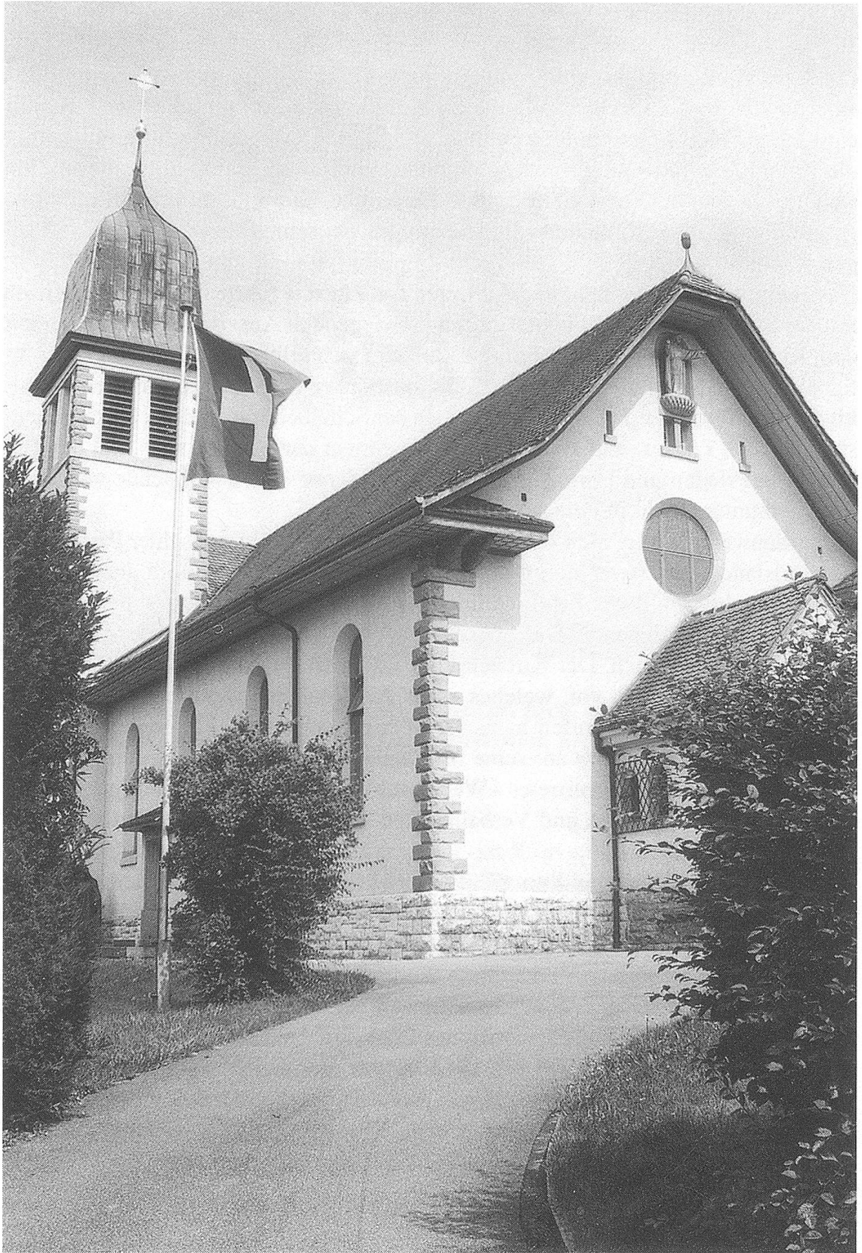
Aussenansicht der im Jugendstil erbauten Herz Jesu-Kirche in Stein am Rhein. (Bild: Luca Geissmann, Neuhausen am Rheinfall, 1998)
