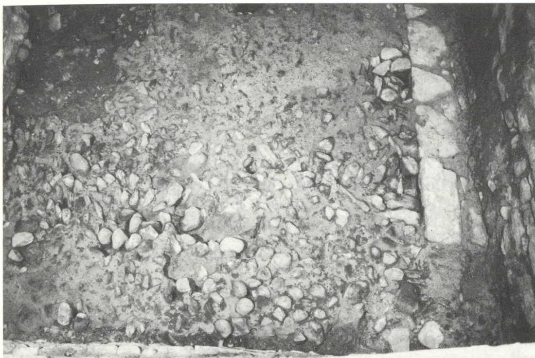
Abb. 13 Mörtelgussboden des zweiten Kirchenschiffes im ehemaligen gotischen Beinhaus. Er bedeckt die Südwand und den Reliquienbehälter der ersten Kirche und integriert die bodeneben abgebrochene Schranke (rechts). (Vgl. Abb. 7).
